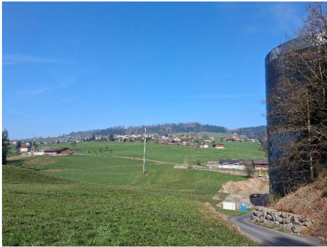
Haltikon (SZ), Blick nach Udligenswil
